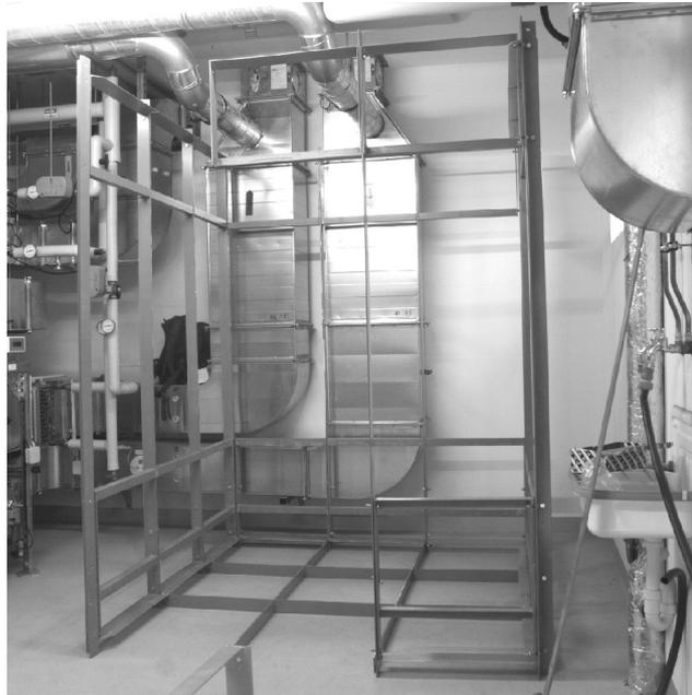
*Abb. 3: Rahmenkonstruktion des modularen Pufferspeichers, teilweiser Aufbau*
