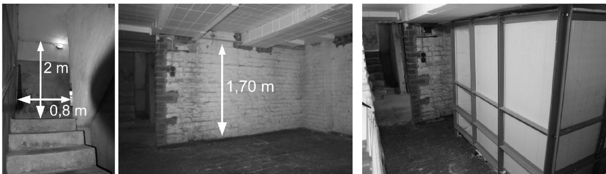
Abb. 4: Einbringung des Speichers ( $4,2\text{ m}^3$ ) in einem Bestandsgebäude: Beengter Zugang zum Kellerraum (l.), niedrige Raumhöhe (m), realisierter Speicher mit optimaler Raumausnutzung (r.)
